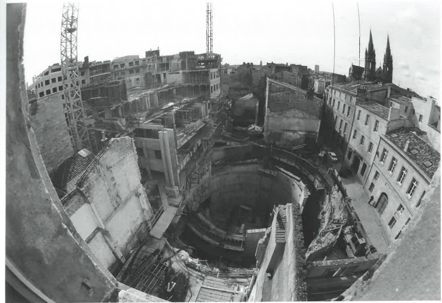
Chantier de la construction de la Cité mondiale, en avril 1991. © Sud Ouest, Michel Lacroix.
